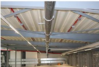
**Sprinkler haben Vorrang:** Die Entwässerungsleitungen sind so platziert, dass sie die Sprinklerfunktion nicht behindern.
