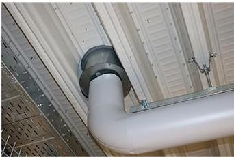
**Brandsichere kleine Durchdringung,** normgerecht ausgeführt mit dem SitaFiresafe, der brennbare Bauteile wie ein Safe vor Feuer schützt.
