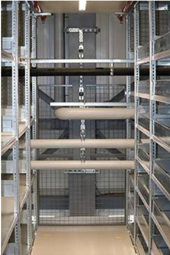
**Die Hauptentwässerung ist gedämmt**, um zu vermeiden, dass sich Kondensat/Schwitzwasser bildet. Die Notentwässerung wurde nicht gedämmt, da sie nicht so häufig anspringt.
