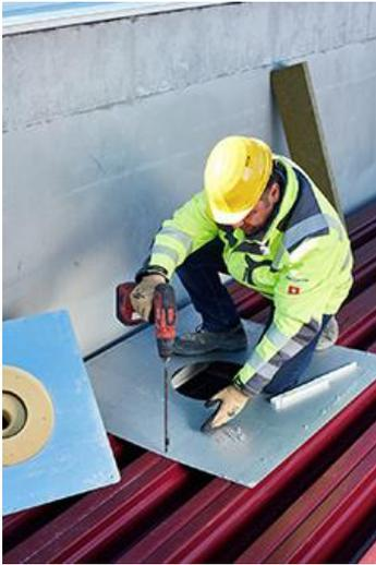
**Verstärkungsblech als solide Basis für den Gullyeinbau.** Voraussetzung bei Stahltapezblech-Konstruktionen.
