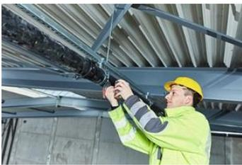
**Die solide Rohrbefestigung** mit Schienen und Schellen des SitaMontagesystems fängt Bewegungen innerhalb des druckbeaufschlagten Rohrsystems sicher auf.
