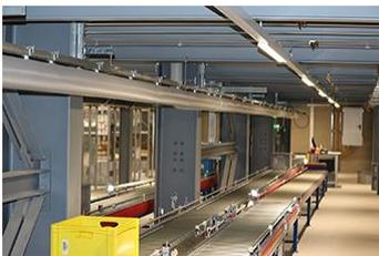
**Platzsparend platziert:** Die Entwässerungsleitung verläuft direkt über dem Förderband.
