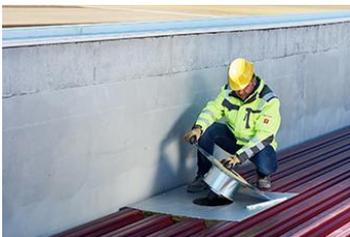
**Einbau des SitaFiresafes®** mit Verstärkungsblech und Sickenfüllern.
