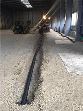
**Vollsickerrohre werden unter der Bodenplatte verlegt.**
