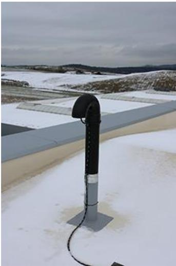
**Sita Vent Rohrdurchführung DN100**, unten ebenfalls eingebettet in einen SitaFiresafe.
