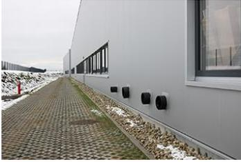
**Die Notentwässerung an der Längsseite der Halle 8** führt das Regenwasser direkt auf schadlos überflutbare Außenflächen.
