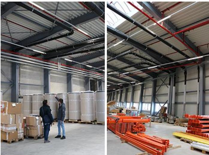
**Abnahme der Druckentwässerung:** Sind die Festpunkte des Rohres richtig ausgebildet? Wurden die Nennweiten eingehalten, die Schellenabstände beachtet und die Befestigung an der Schiene korrekt ausgeführt?
